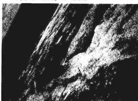
圖1 防波堤面受波浪沖蝕及磨損作用所造成之嚴重災害。
