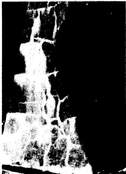
圖 11 由於鹼性骨材反應與乾濕循環共同作用下，造成鋼筋混凝土防浪牆發生龜裂與出現滲出物之現象。
