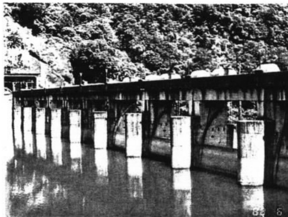
照片 3 水力電廠閘門
