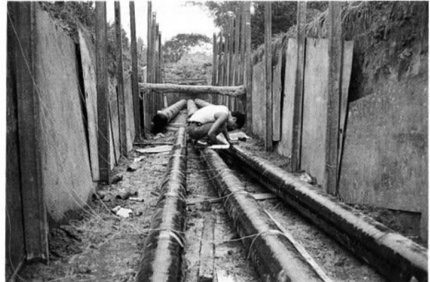
照片二 現場實驗 Photo 2 Field test.
